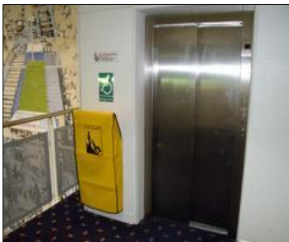
Figura 4.14 – Espaço para armazenar cadeira de evacuação.
