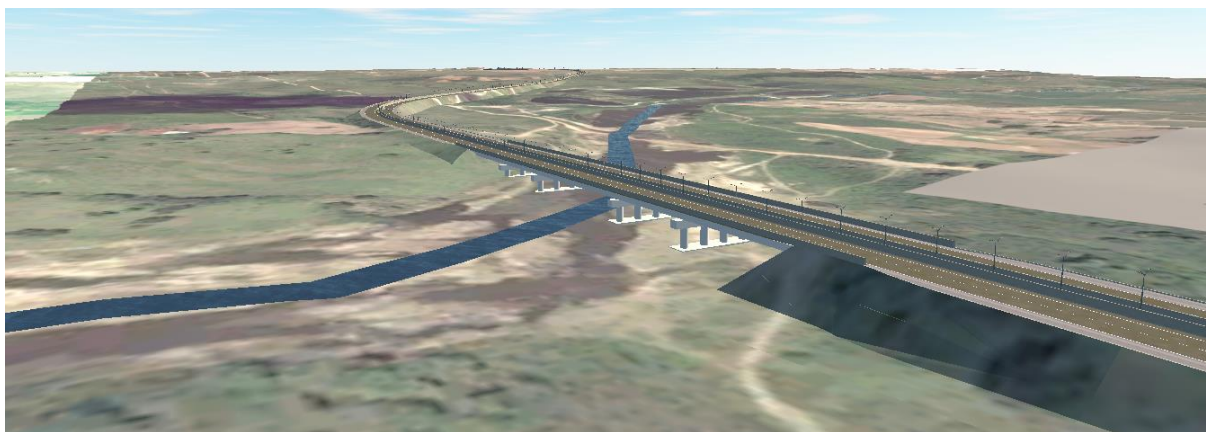
Figura A.2, Ponte sobre o rio Potengi, Acesso Sul ao Aeroporto de São Gonçalo do Amarante
