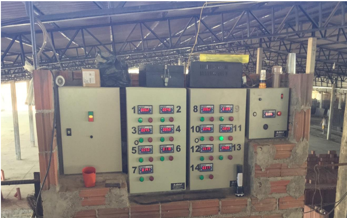
Imagem 03: Fotografia do painel de controle das câmaras de vapor (fornos). Fonte: Elaborado pelo autor (2015)
