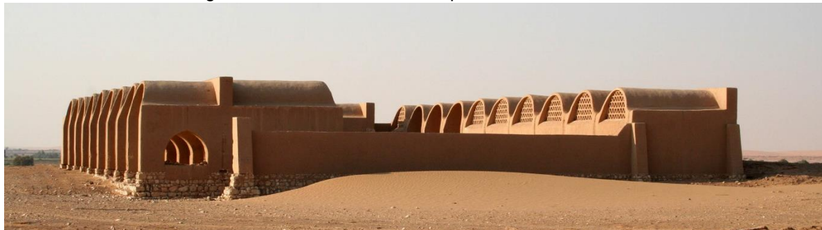
Figura 100: Vista lateral do complexo do Mercado Souk
