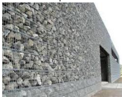
Figura 30: Parede de Gambiões em pedras locais
