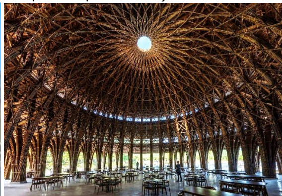
Figura 47: Interior do Restaurante Vedana, pilares e padrões trançados de bambu
