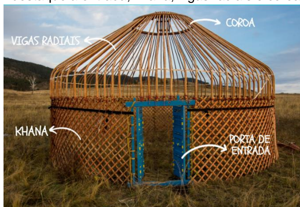
Figura 162: Estrutura de um yurt tradicional - destaque a entrada, khana, vigas radiais e coroa.
