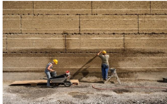
Figura 28: paredes do Centro de Ervas em terra e outros materiais locais.
