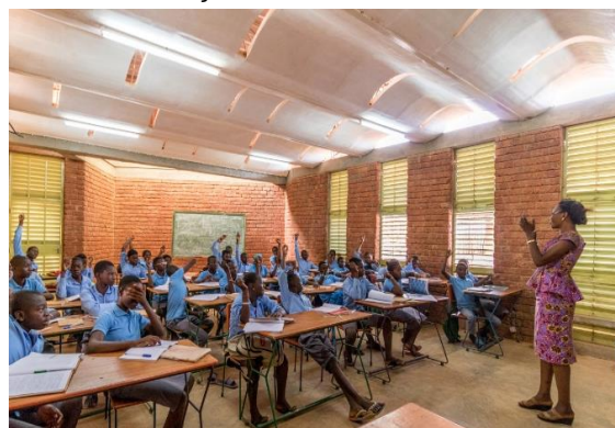
Figura 116: forro de gesso perfurado para iluminação interna das salas de aula.
