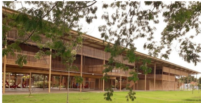
Figura 93: Complexo erguido por pilotis de madeira
