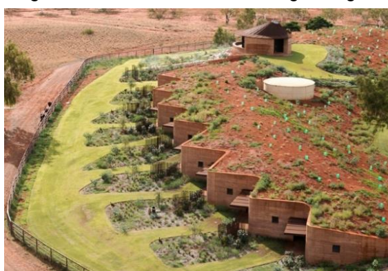
Figura 200: Parede de terra em zigue-zague
