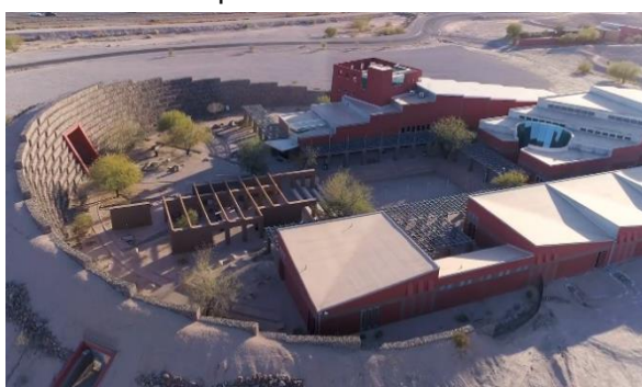
Figura 68: Edifícios convencionais do centro envolvidos pela berma de terra circular.
