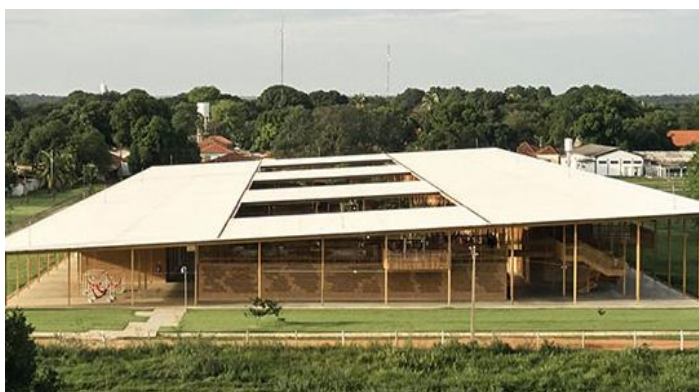
Figura 84: Complexo das Moradias pontuada por pilares de MLC, sob uma mesma cobertura contínua de metal.
