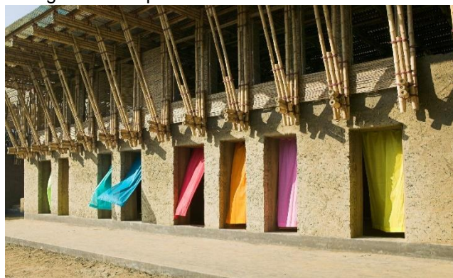
Figura 151: Fachada posterior do edifício com largo telhado que se estende além da área da obra
