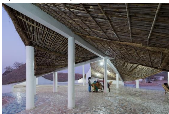
Figura 125: Telhado em bambu e palha sobre pilares brancos e piso cerâmico em mosaico
