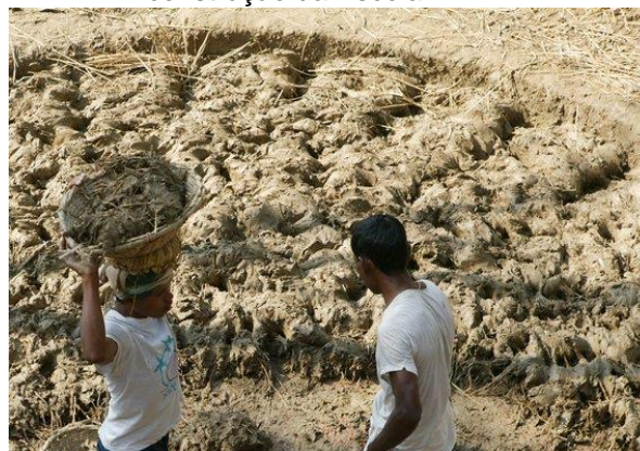
Figura 146: Produção de Cob para a construção da Escola METI
