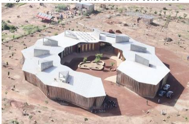
Figura108: Vista superior do edifício construído
