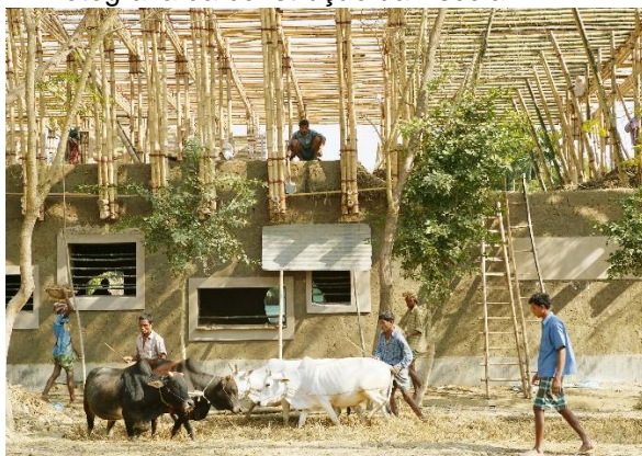
Figura 145: Estrutura mista em cob e bambu fotografia da construção da Escola METI
