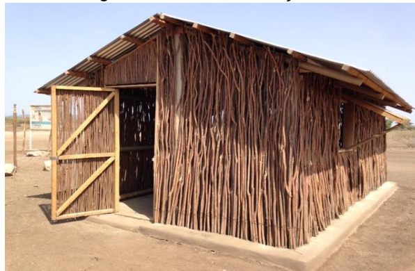
Figura 33: Modelo experimental de abrigo em galhos de árvores trançados
