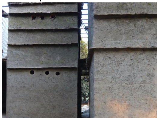
Figura 150: Lombadas de bambu nas paredes de terra da obra
