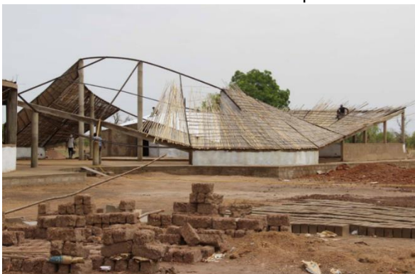
Figura 124: Foto da construção da obra em BTCs e sistemas em bambu e palha local
