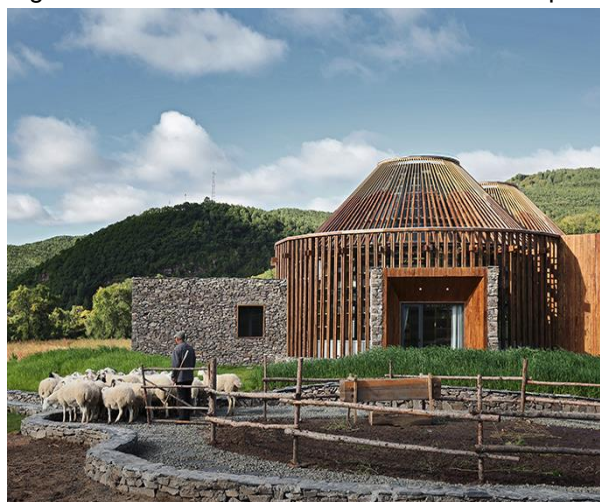
Figura 169: Fachada do centro em madeira e pedra
