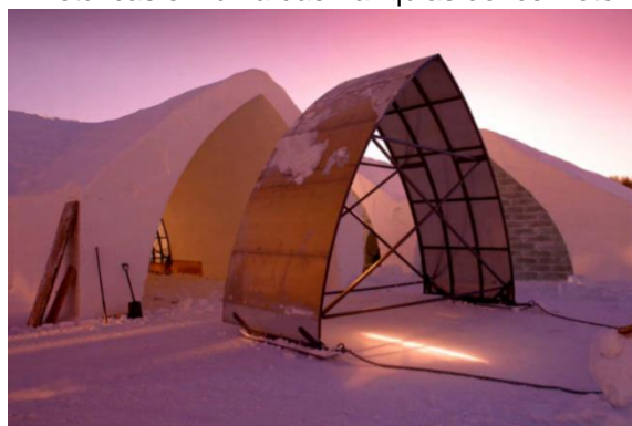
Figura 186: Moldagem da neve com formas metálicas em uma das franquias do Ice Hotel
