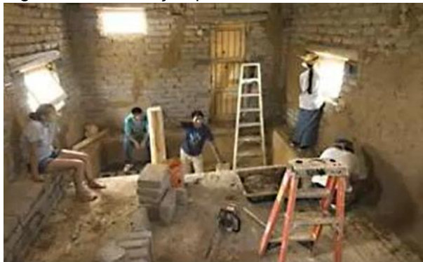
Figura 57: Construção-paredes de adobe do Poeh Figura 58: Construção-piso das galerias de artes
