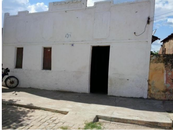
Figura 10 - Residência na rua Isidório Antunes de Oliveira
