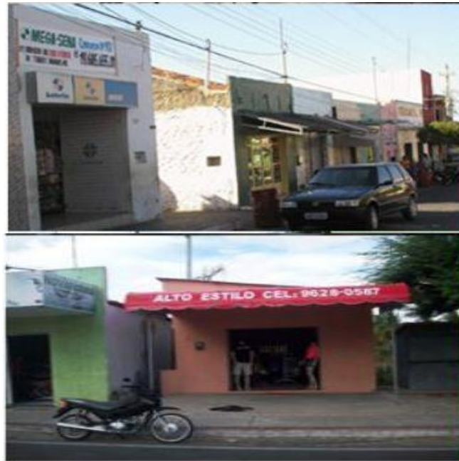
Figura 14 - Prédios comerciais da cidade de Tenente Ananias Estes prédios retratam a estrutura construtiva de uma pequena cidade caracterizada pela simplicidade das edificações e de pavimento único. Fonte: Imagens capturadas na internet.
