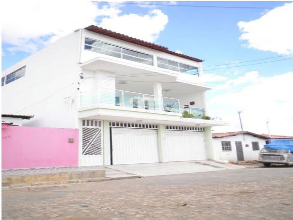
Figura 28 – Prédio residencial com três pavimentos contrastando com casas mais simples.
