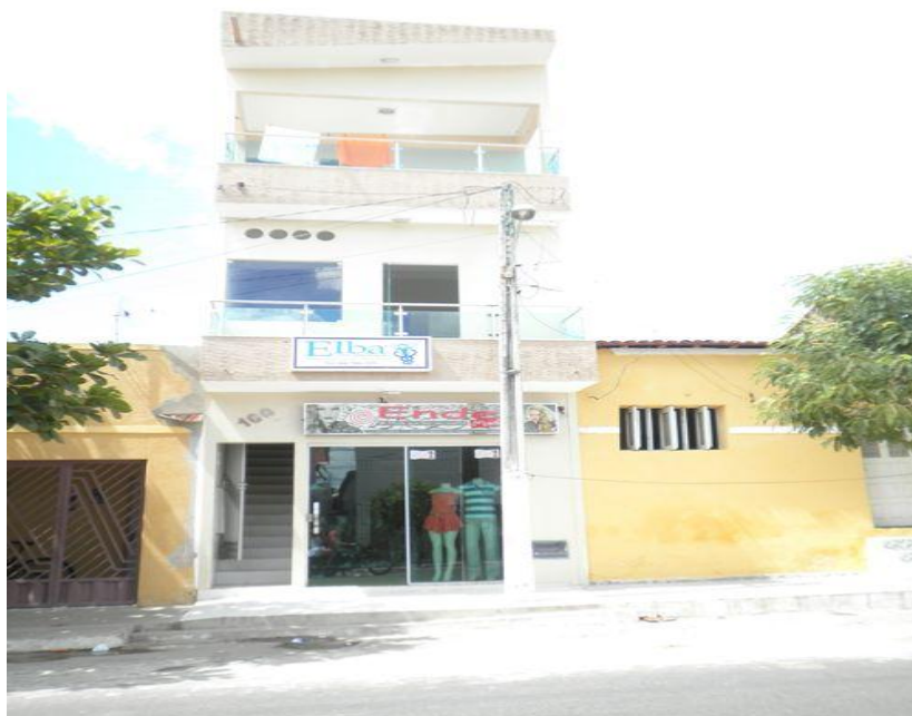
Figura 29 – Prédio “multifuncional” com três pavimentos.
