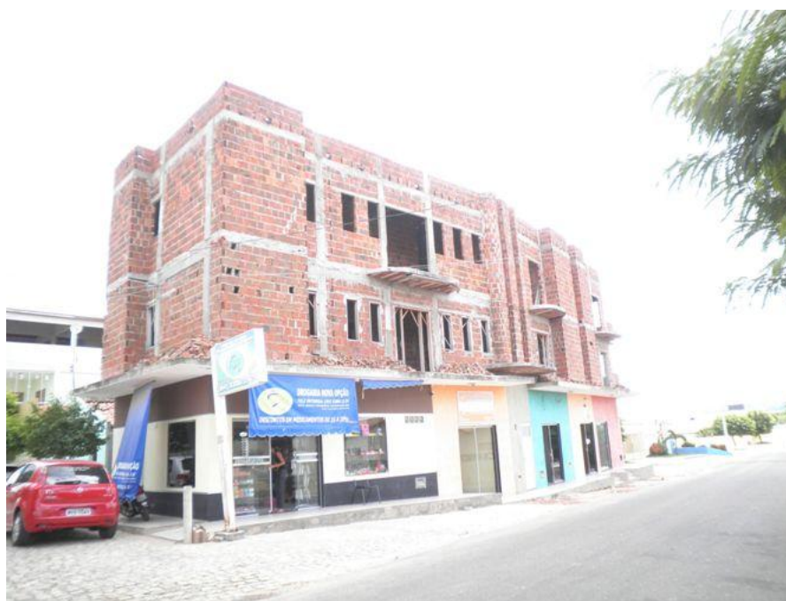
Figura 33 – Prédio em reforma e ampliação. Fonte: Arquivo pessoal do autor.
