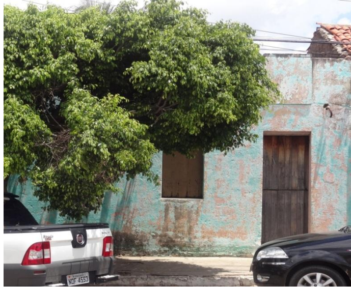
Figura 2 - Fachada da residência de número 420 na Rua José Moreira do Nascimento
