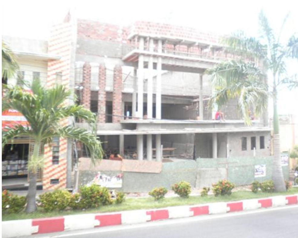
Figura 39 – Construção do novo supermercado “O Barateiro” . Fonte: Arquivo pessoal do autor.
