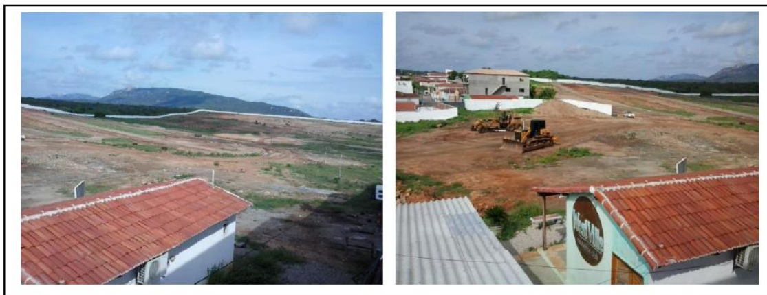
Figura 46 – Parte da área do Condomínio Club West Ville. O condomínio horizontal será o primeiro empreendimento fechado na cidade e terá uma infraestrutura de clube. Fonte: Arquivo pessoal do autor.
