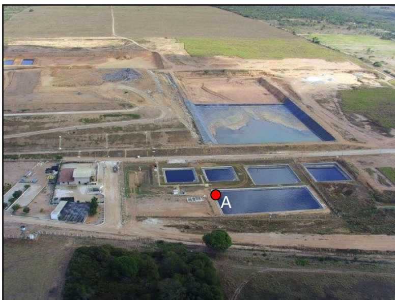
Figura 04 – Vista aérea do ASRMN com destaque para sua estação de tratamento de percolado. O ponto vermelho com a letra A indica o local da coleta.
