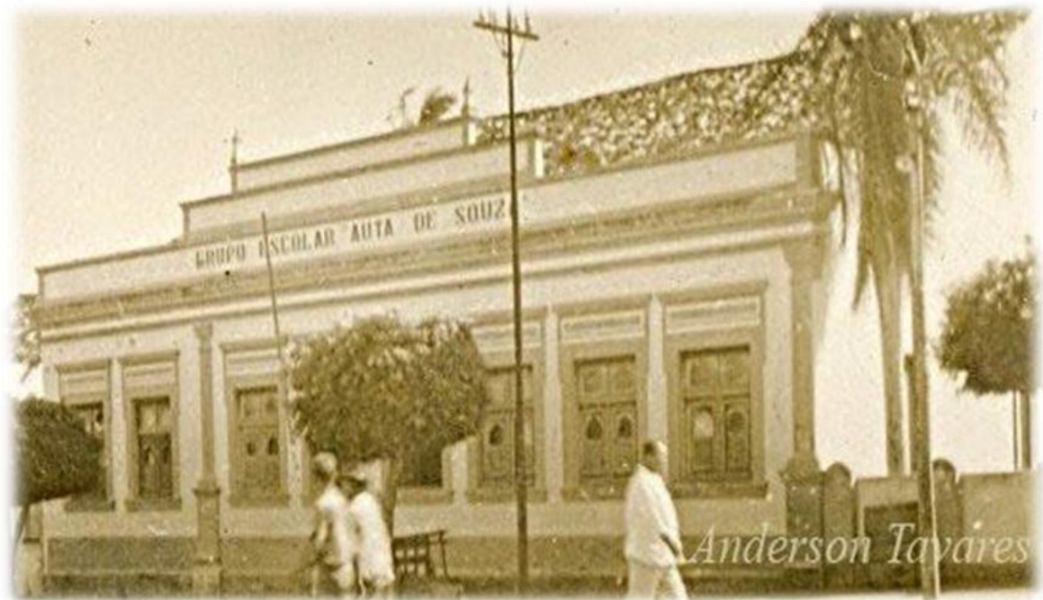
FIGURA 5: Prédio onde serviu de residência à família Castriciano de Souza na então Rua do comércio em Macaíba. No momento em que foi fotografado, já funcionava como escola desde 1911. Hoje não possui mais esta aparência 53 .
