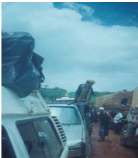
Foto 9 – Condições da Rodovia Transamazônica entre Altamira e Medicilândia.
