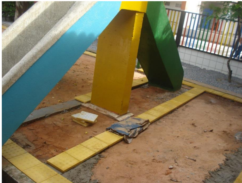
Figura 12 – Reforma do parquinho da Escola
