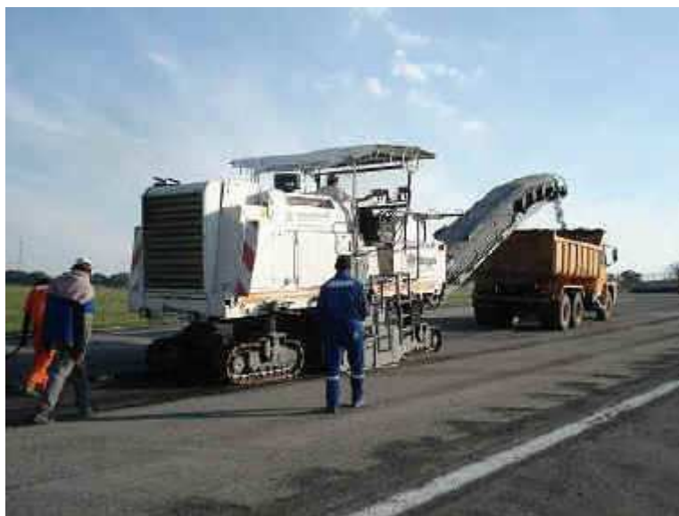
Figura 2.1: Ilustração de fresadora asfáltica em operação
