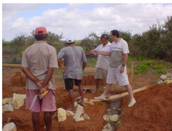
Figura 45: Mutirão do assentamento Maria da Paz durante a execução das fundações das moradias
