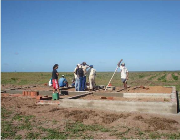
Figura 55: Acompanhamento da etapa de fundação das moradias do assentamento Resistência Potiguar 1
