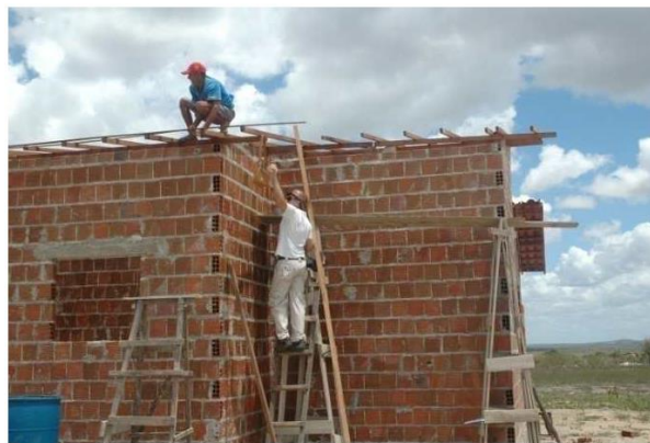
Figura 36: Acompanhamento da cobertura das moradias.
