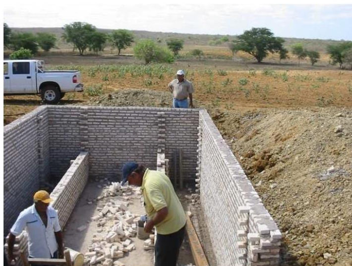
Figura 46: Mutirão para construção do sistema de tratamento de esgoto do assentamento Maria da Paz
