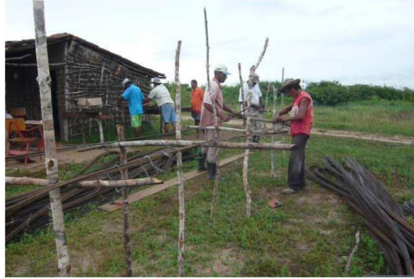
Figura 35: Mutirantes pré-fabricando estruturas para as moradias do assentamento Roseli Nunes.
