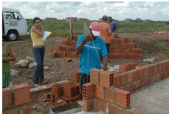
Roseli Nunes no início da etapa de alvenaria Fonte: GERAH, 2009.
