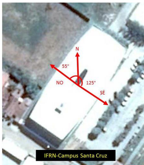
Figure 15 – Vista superior do local de instalação da UFV IFRN – Santa Cruz. FONTE: Memorial descritivo do projeto.
